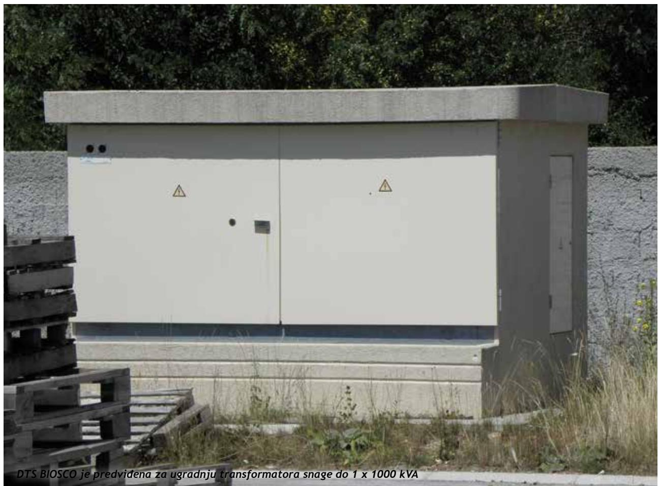
DTS BIOSCO je predviđena za ugradnju transformatora snage do 1 x 1000 kVA
