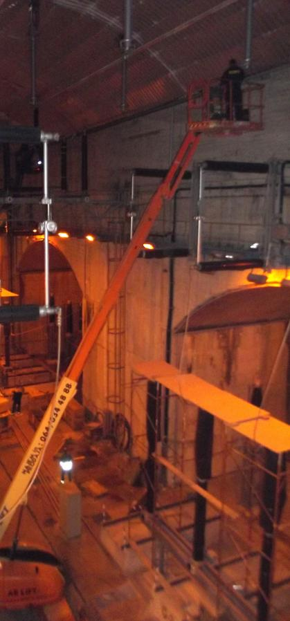
Montaža nosećih izolatora sabirnica 220 kV
