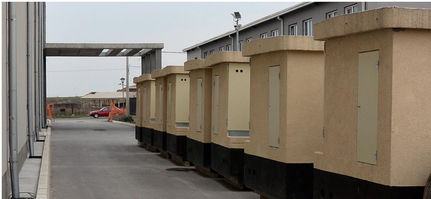
Trafostanice Biosco CS 10(20)/0,4 kV 1x630 kVA ispred proizvodnog pogona u Beogradu
