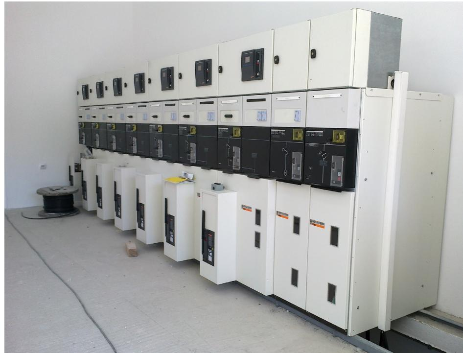
Postrojenje 10 kV tip SM6, proizvođača Schneider Electric-Merlin Gerin
