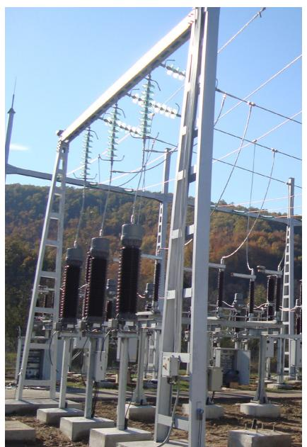
Naponski mjerni transformatori 110 kV montirani ispod portala
