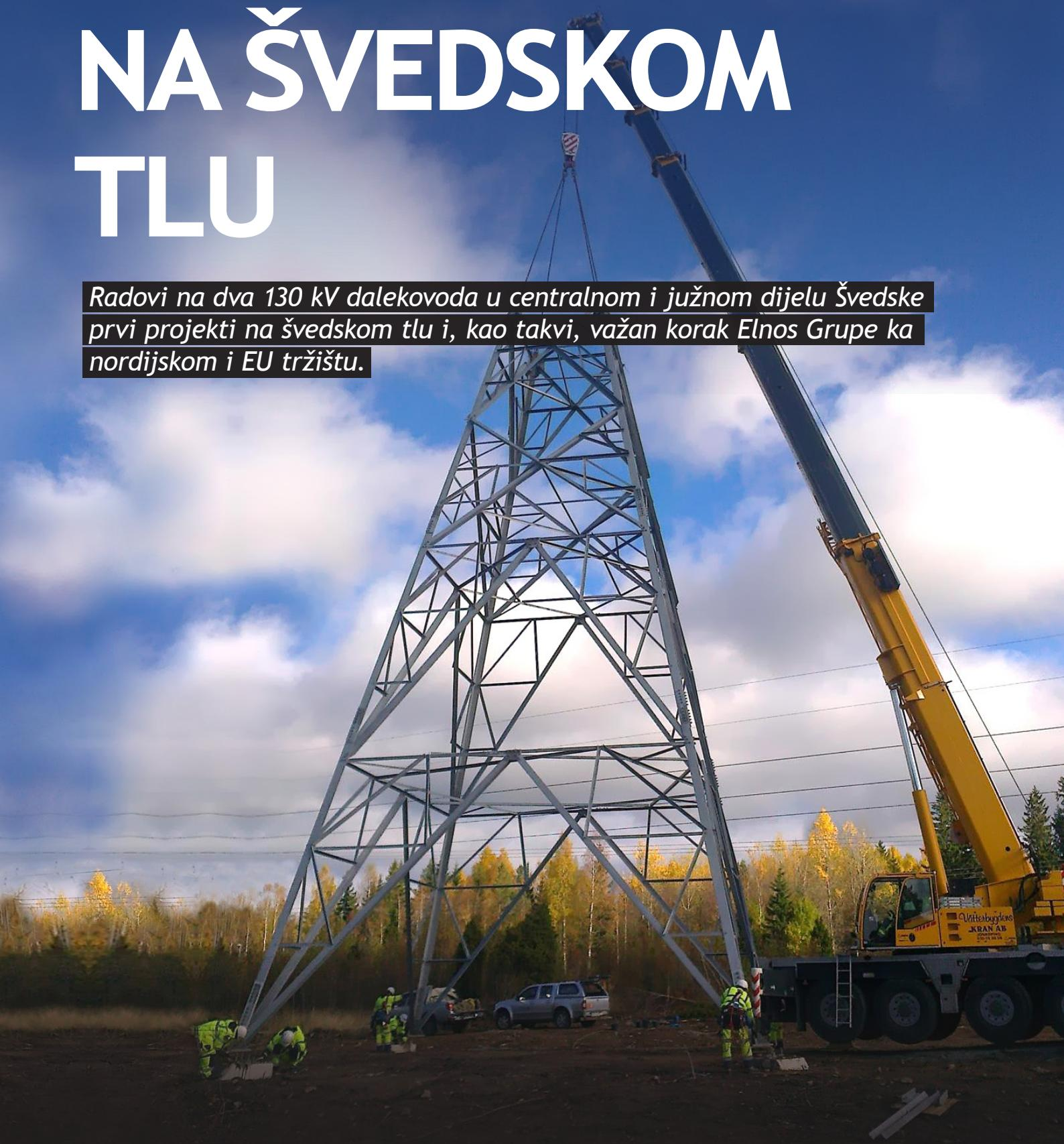
DV 2x130 kV Barkeryd -Nässjö: zatezni stub tip: S - 1, težina stuba: 35 t, visina stuba: 40 m
