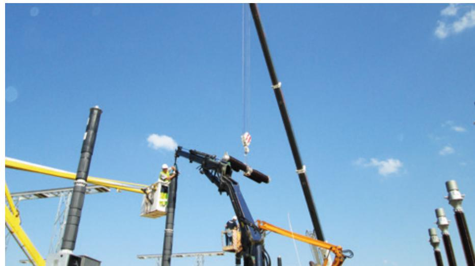
Montaža aktivnog dijela 400 kV prekidača snage / Installation of the active parts of 400 kV power switch
