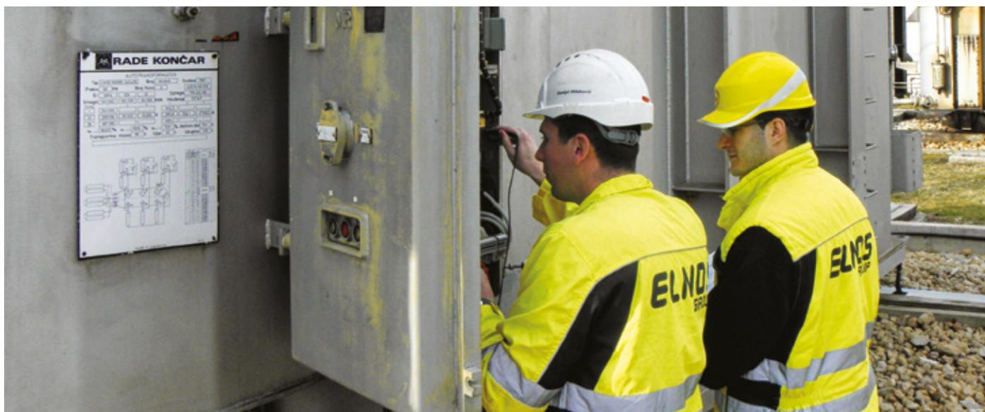
Funkcionalno ispitivanje transformatorskog polja / Functional test of transformer bay
