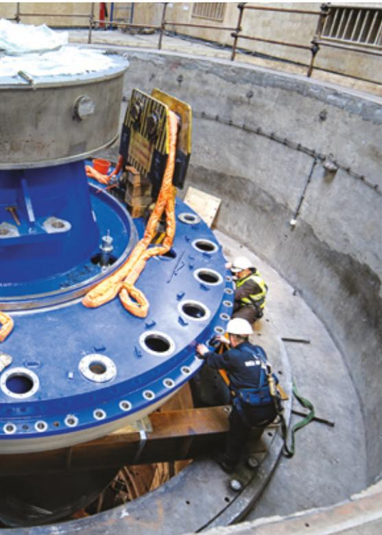
Montaža vertikalne Kaplan turbine
