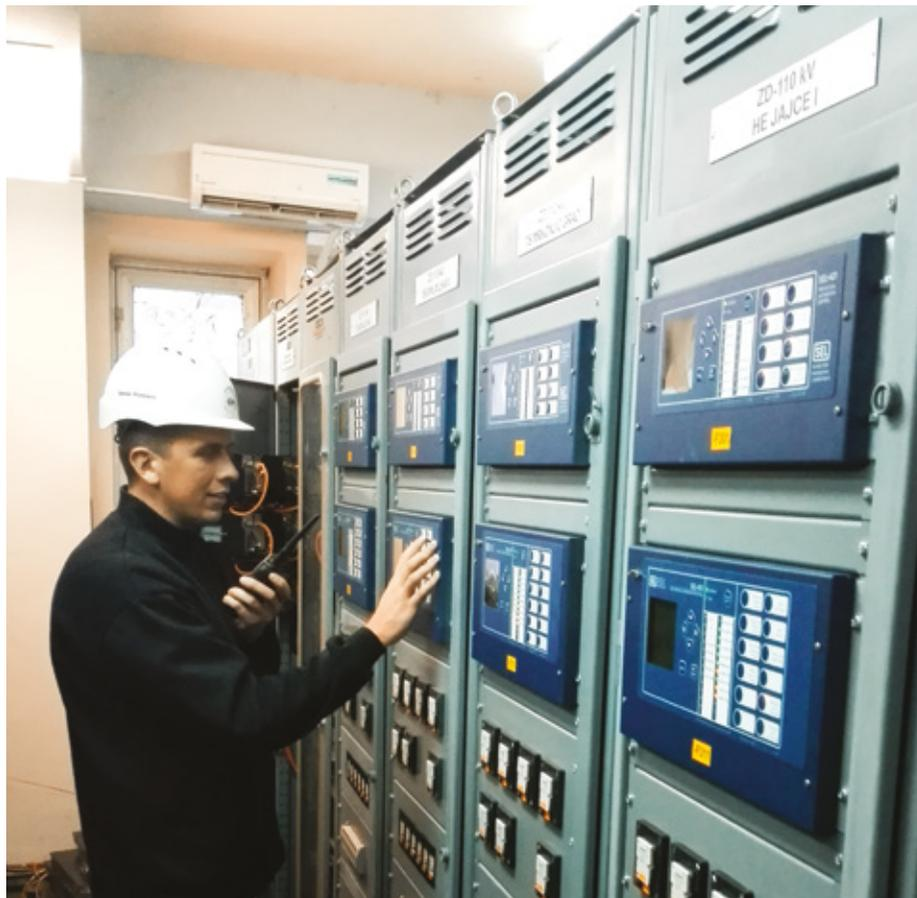
**Funkcionalno ispitivanje – zaštitno-upravljački ormari 110 kV DV polja**
