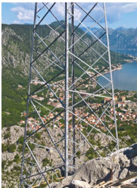
**Dvostruki 110 kV stub visine 17,7 m**
