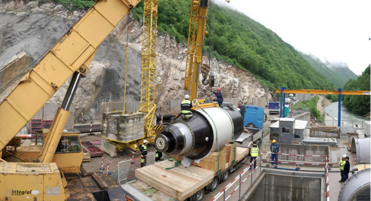
Spuštanje turbinskog agregata težkog 55 t Submerging of 55 t turbine generator
