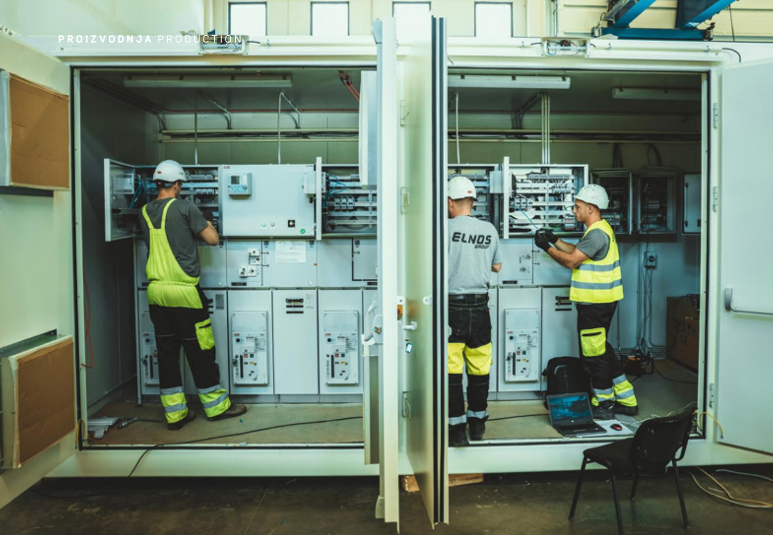
Distributivne trafostanice smo „skrojili po mjeri“ projekta HS2 Custom-made distribution substations for HS2 project
