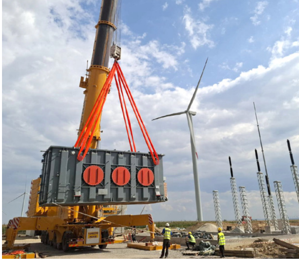
Montaža energetskog transformatora teškog 260 t Assembling a power transformer weighing 260 t
