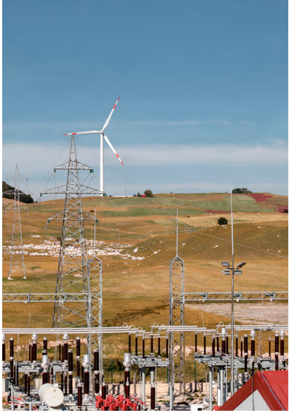
Izvodimo e-BoP poslove na VP Gvozd (54,6 MW) E-BoP works at WP Gvozd (54.6 MW)
