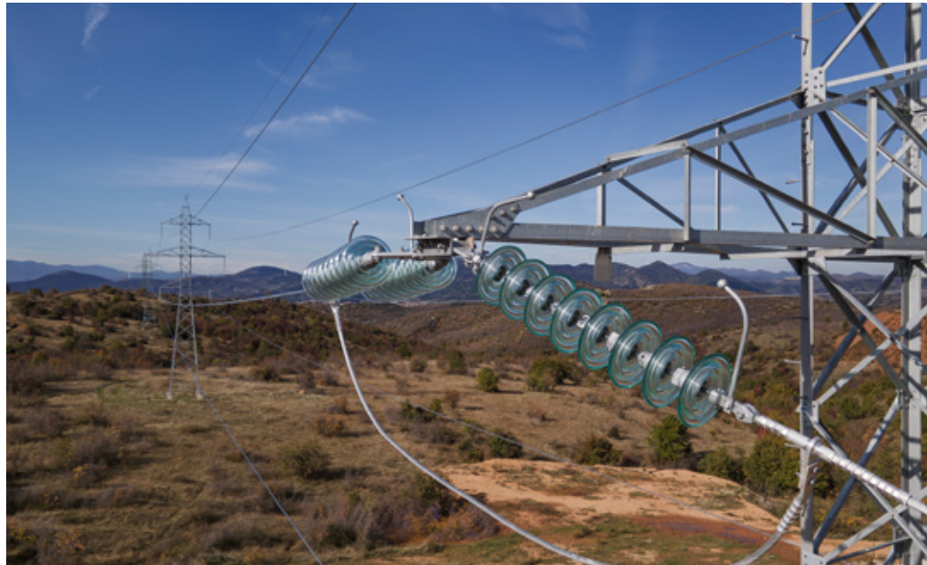
Duž trase će biti podignuto 309 stubova 309 towers along the route
